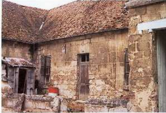
La maison de Saint-Just en 1989, lors de son achat. Avec sa toiture crevée, son pignon éventré et ses pierres de façade très dégradées, elle menaçait ruine.
