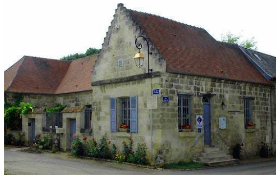
La Maison en 2012, avant l'incendie.
